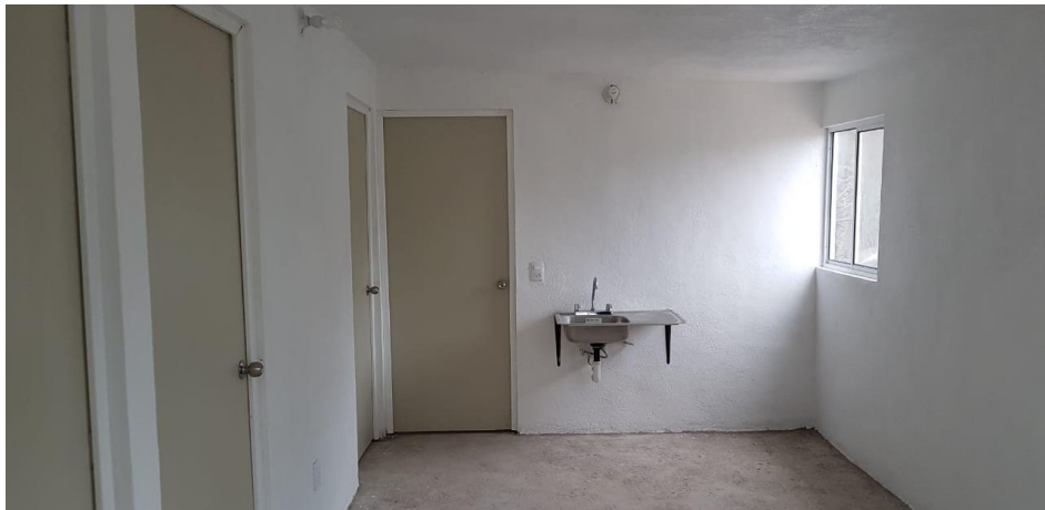
VISTA INTERIOR Y COLOCACIÓN DE TARJA
