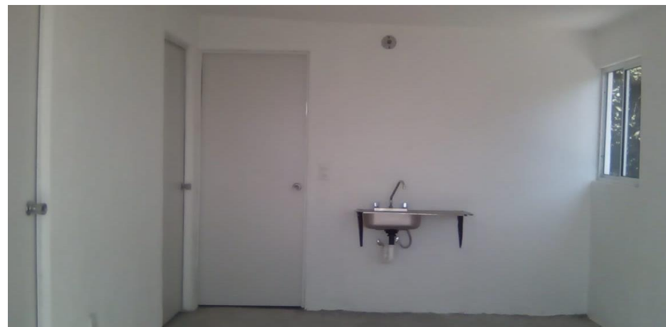
VISTA INTERIOR Y COLOCACIÓN DE TARJA
