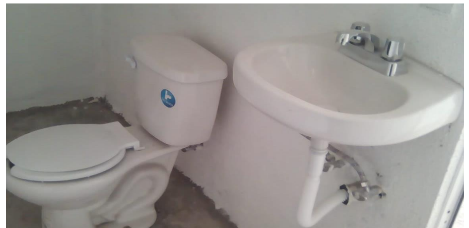
COLOCACIÓN DE MUEBLES DE BAÑO
