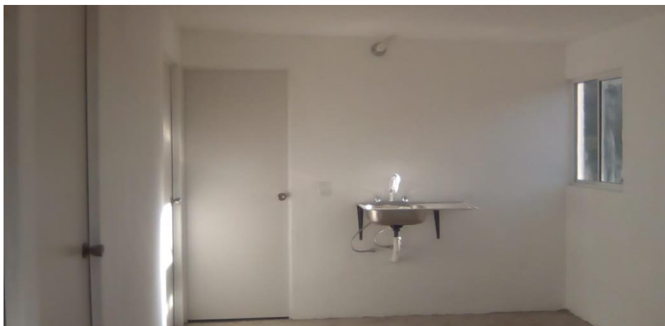
VISTA INTERIOR Y COLOCACIÓN DE TARJA
