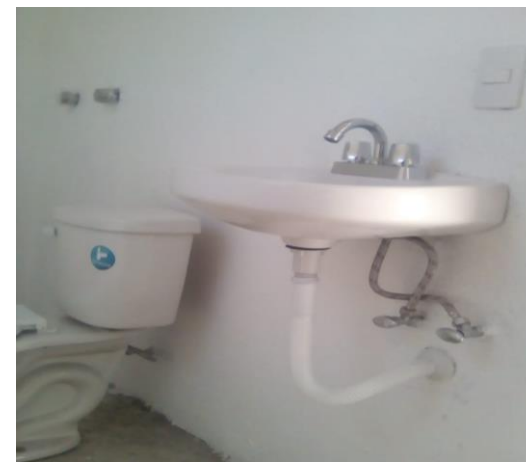
COLOCACIÓN DE MUEBLES DE BAÑO
