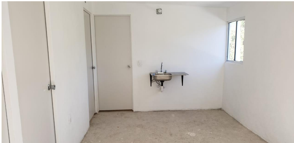
VISTA INTERIOR Y COLOCACIÓN DE TARJA
