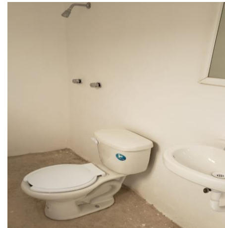
COLOCACIÓN DE MUEBLES DE BAÑO
