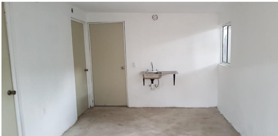
VISTA INTERIOR Y COLOCACIÓN DE TARJA
