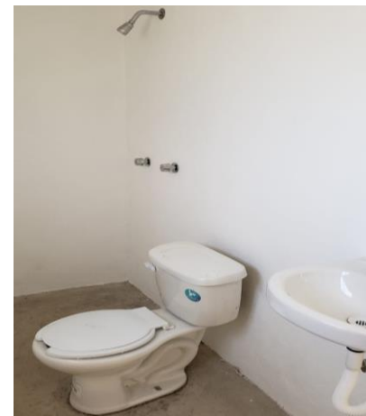
COLOCACIÓN DE MUEBLES DE BAÑO
