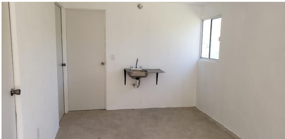
VISTA INTERIOR Y COLOCACIÓN DE TARJA
