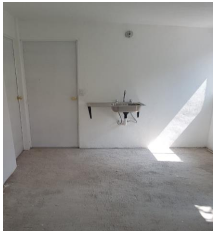
VISTA INTERIOR Y COLOCACION DE TARJA
