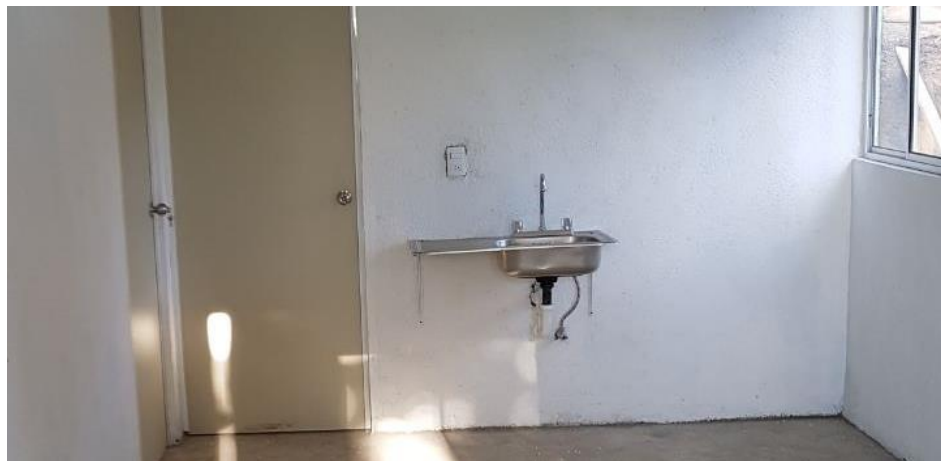
VISTA INTERIOR Y COLOCACION DE TARJA
