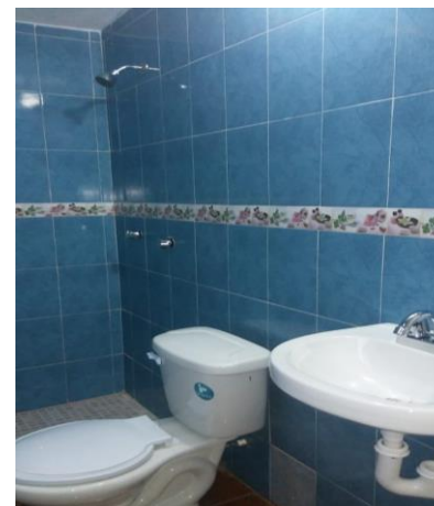
COLOCACIÓN DE MUEBLES DE BAÑO
