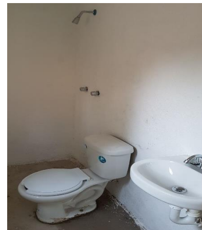
COLOCACION DE MUEBLES DE BAÑO
