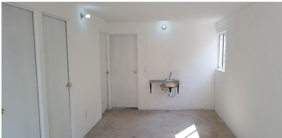
VISTA INTERIOR Y COLOCACION DE TARJA
