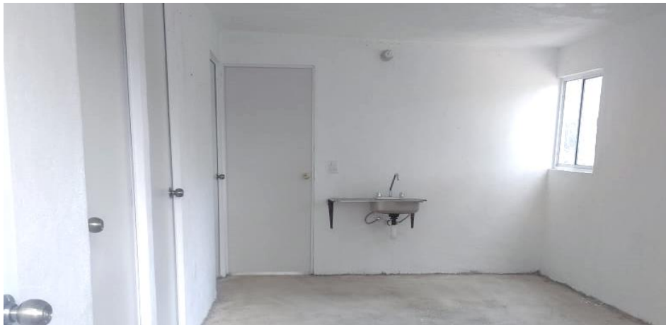
VISTA INTERIOR Y COLOCACIÓN DE TARJA
