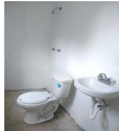
COLOCACIÓN DE MUEBLES DE BAÑO
