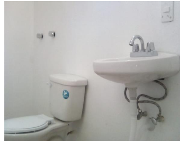
COLOCACIÓN DE MUEBLES DE BAÑO
