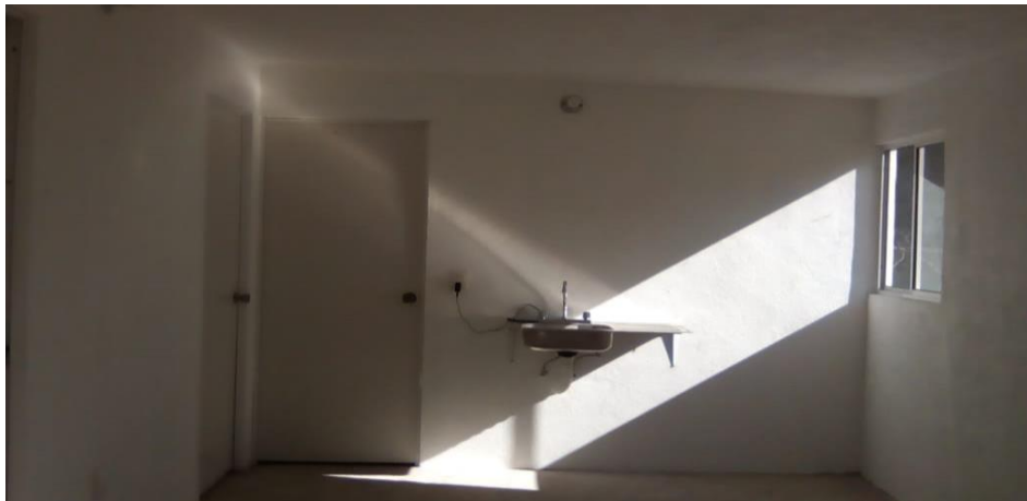
VISTA INTERIOR Y COLOCACIÓN DE TARJA
