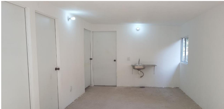
VISTA INTERIOR Y COLOCACION DE TARJA
