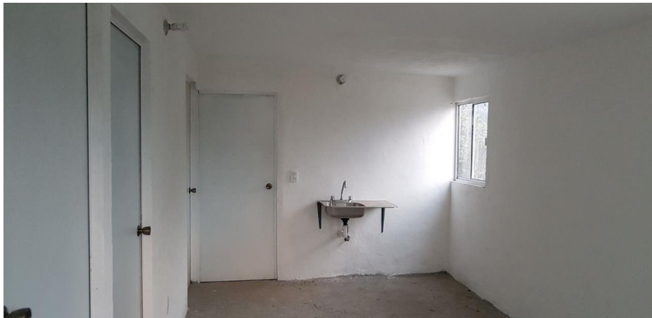
VISTA INTERIOR Y COLOCACION DE TARJA
