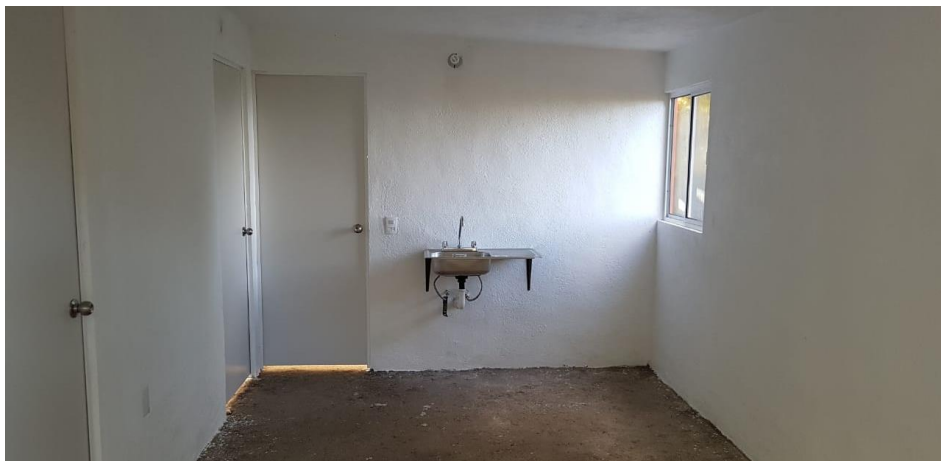
VISTA INTERIOR Y COLOCACIÓN DE TARJA
