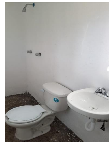
COLOCACIÓN DE MUEBLES DE BAÑO
