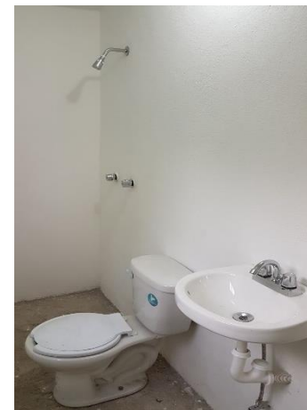
COLOCACION DE MUEBLES DE BAÑO
