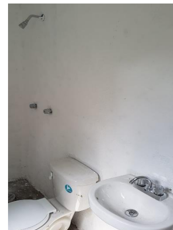
COLOCACIÓN DE MUEBLES DE BAÑO
