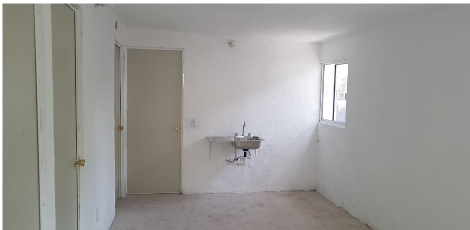
VISTA INTERIOR Y COLOCACIÓN DE TARJA
