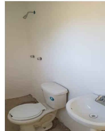
COLOCACIÓN DE MUEBLES DE BAÑO
