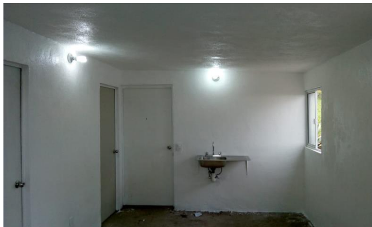
VISTA INTERIOR Y COLOCACIÓN DE TARJA
