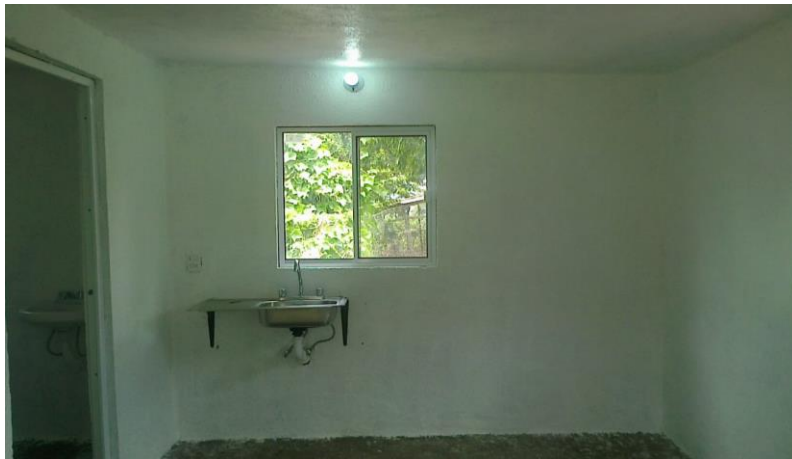
VISTA INTERIOR Y COLOCACIÓN DE TARJA
