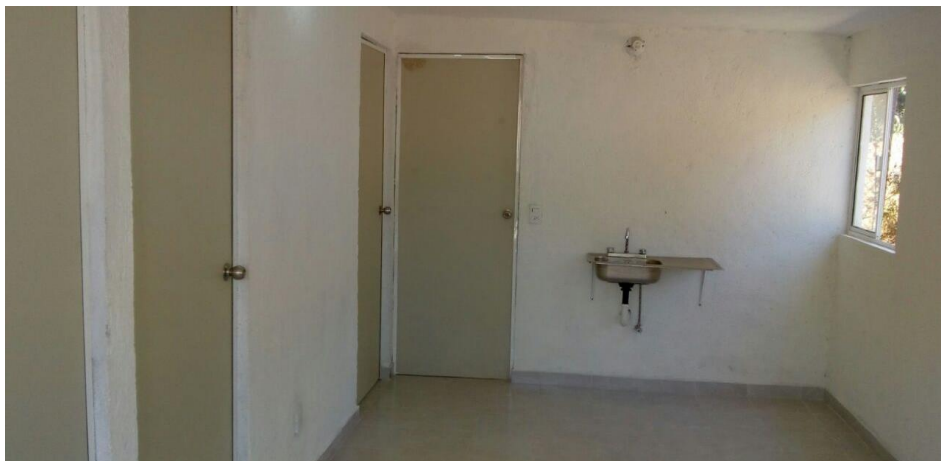
VISTA INTERIOR Y COLOCACION DE TARJA
