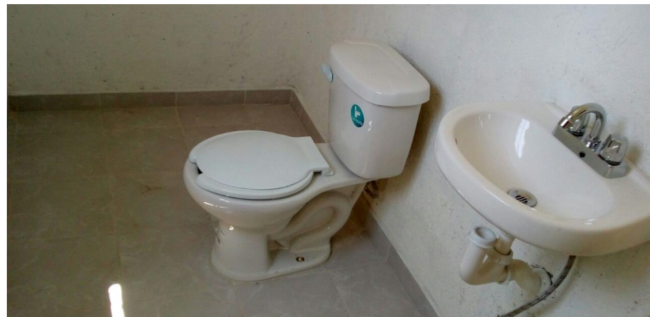
COLOCACION DE MUEBLES DE BAÑO
