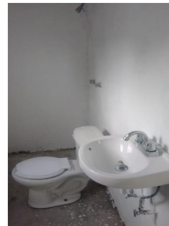
COLOCACIÓN DE MUEBLES DE BAÑO
