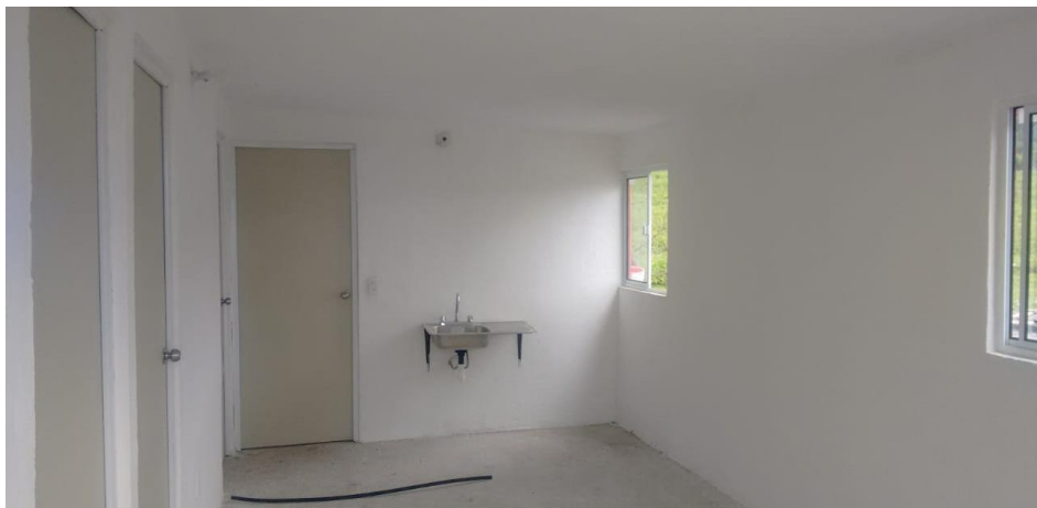
VISTA INTERIOR Y COLOCACIÓN DE TARJA
