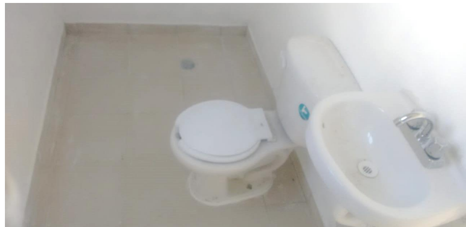
COLOCACIÓN DE MUEBLES DE BAÑO
