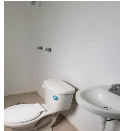
COLOCACIÓN DE MUEBLES DE BAÑO
