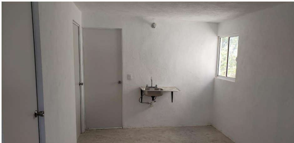
VISTA INTERIOR Y COLOCACIÓN DE TARJA
