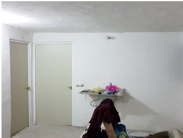
VISTA INTERIOR Y COLOCACIÓN DE TARJA
