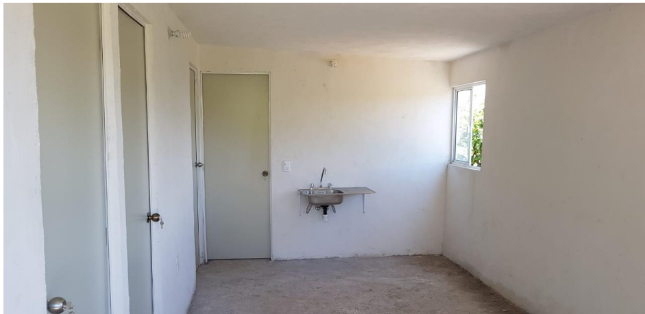
VISTA INTERIOR Y COLOCACIÓN DE TARJA
