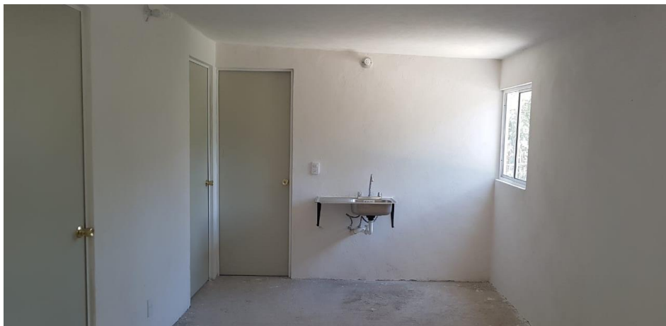
VISTA INTERIOR Y COLOCACIÓN DE TARJA
