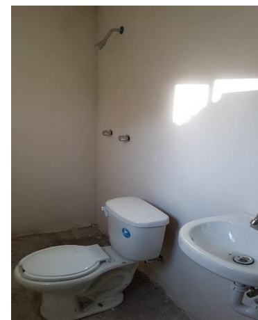
COLOCACIÓN DE MUEBLES DE BAÑOS
