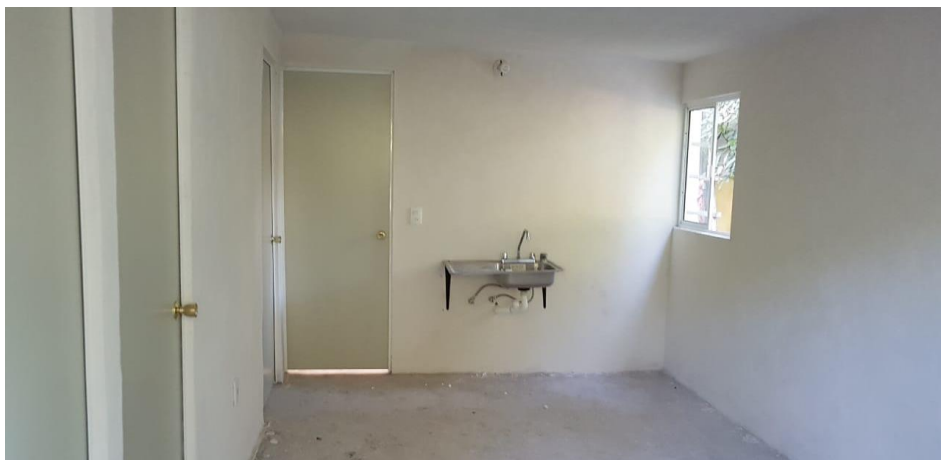
VISTA INTERIOR Y COLOCACIÓN DE TARJA
