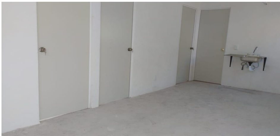
VISTA INTERIOR Y COLOCACIÓN DE TARJA
