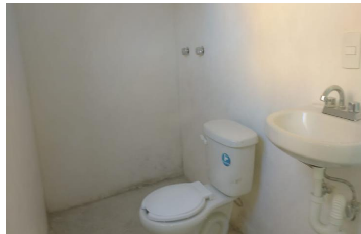
COLOCACIÓN DE MUEBLES DE BAÑOS
