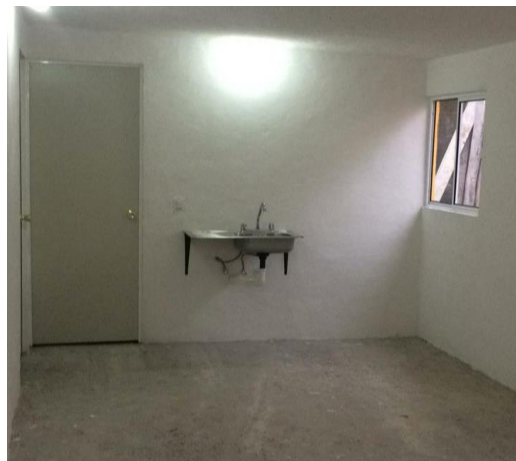
VISTA INTERIOR Y COLOCACIÓN DE TARJA
