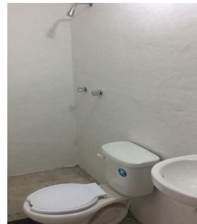
COLOCACIÓN DE MUEBLES DE BAÑOS
