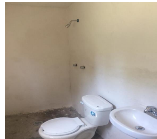
COLOCACIÓN DE MUEBLES DE BAÑO
