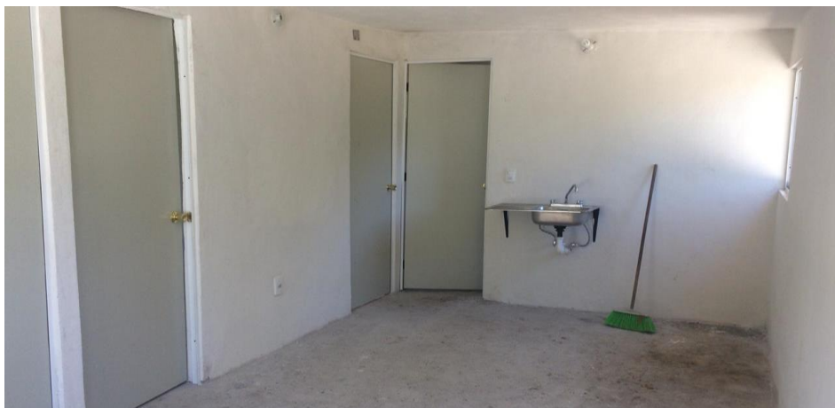
VISTA INTERIOR Y COLOCACIÓN DE TARJA
