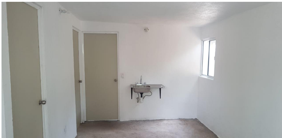
VISTA INTERIOR Y COLOCACIÓN DE TARJA
