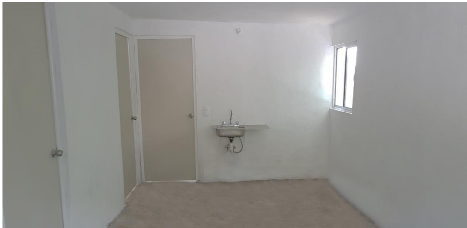
VISTA INTERIOR Y COLOCACIÓN DE TARJA
