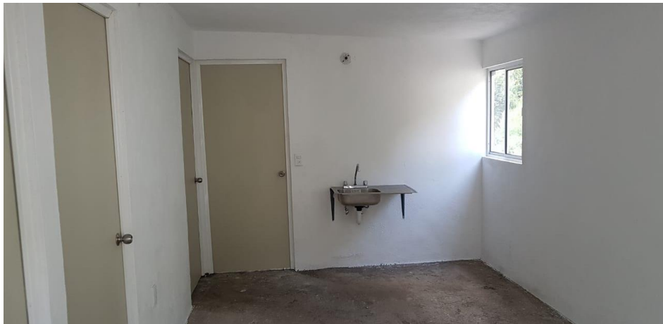
VISTA INTERIOR Y COLOCACIÓN DE TARJA
