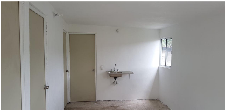
VISTA INTERIOR Y COLOCACIÓN DE TARJA
