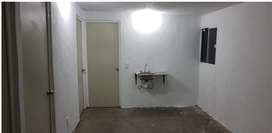
VISTA INTERIOR Y COLOCACIÓN DE TARJA
