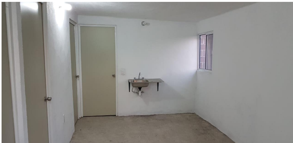
VISTA INTERIOR Y COLOCACIÓN DE TARJA
