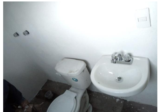
COLOCACIÓN DE MUEBLES DE BAÑO
