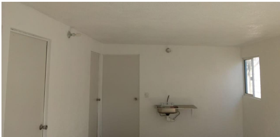
VISTA INTERIOR Y COLOCACIÓN DE TARJA
