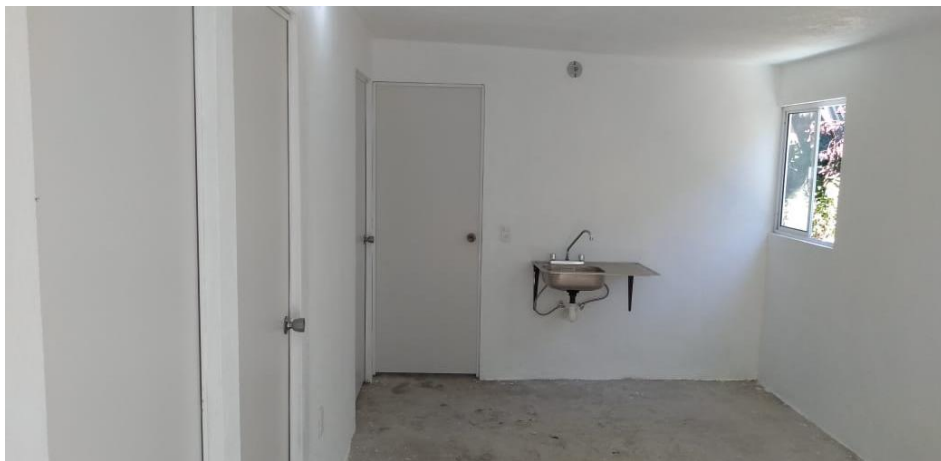
VISTA INTERIOR Y COLOCACIÓN DE TARJA
