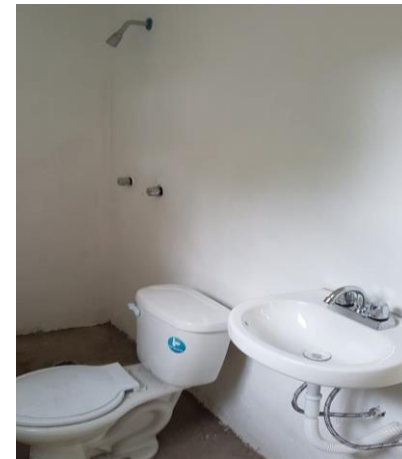
COLOCACIÓN DE MUEBLES DE BAÑO
