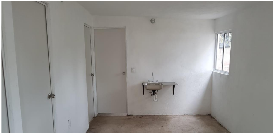
VISTA INTERIOR Y COLOCACIÓN DE TARJA
