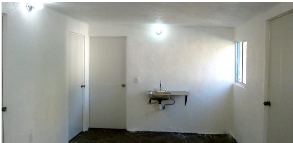
VISTA INTERIOR Y COLOCACIÓN DE TARJA
