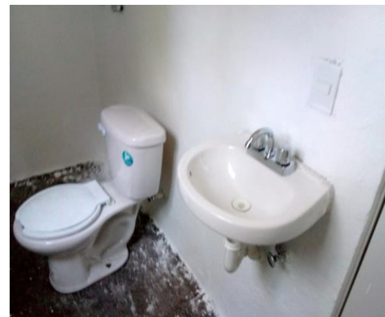
COLOCACIÓN DE MUEBLES DE BAÑO
