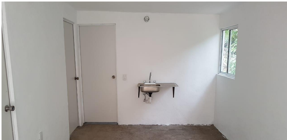
VISTA INTERIOR Y COLOCACIÓN DE TARJA
