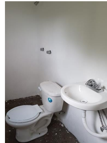
COLOCACIÓN DE MUEBLES DE BAÑO
