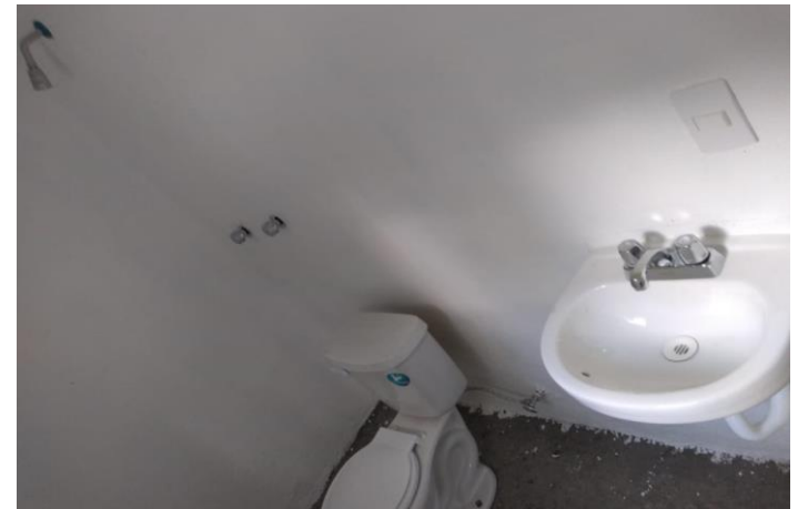
COLOCACIÓN DE MUEBLES DE BAÑO
