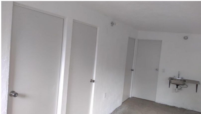
VISTA INTERIOR Y COLOCACIÓN DE TARJA
