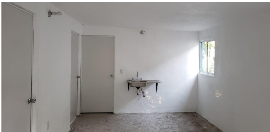
VISTA INTERIOR Y COLOCACIÓN DE TARJA
