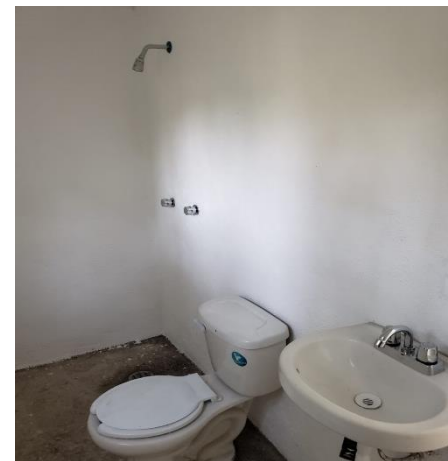
COLOCACIÓN DE MUEBLES DE BAÑO
