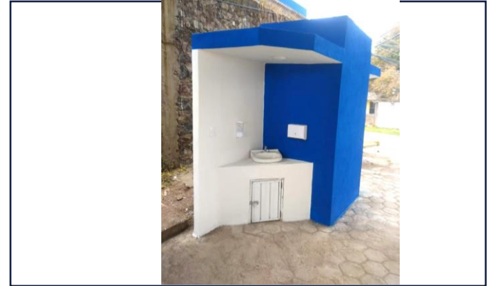
VISTA EXTERIOR ESTACION LAVADO DE MANOS
