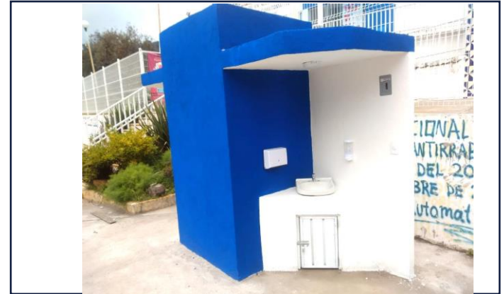
VISTA EXTERIOR ESTACION LAVADO DE MANOS
