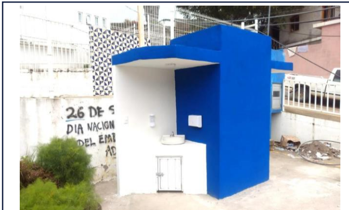
VISTA EXTERIOR ESTACION LAVADO DE MANOS
