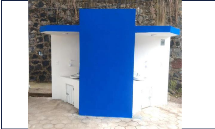
VISTA EXTERIOR ESTACION LAVADO DE MANOS
