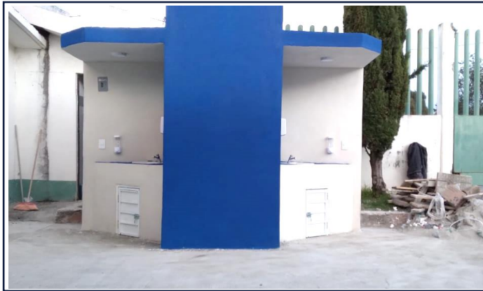
VISTA EXTERIOR ESTACION LAVADO DE MANOS
